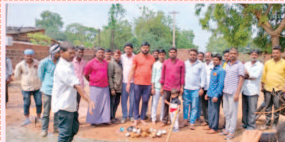
మెటల్‌కుంటలో సిసి రోడ్డు పనులు ప్రారంభిస్తున్న సర్పంచ్ పీటర్‌రాజు
